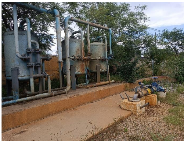
IMAGEN 1. VISTA DEL TREN DE DESCARGA DEL POZO EXISTENTE. A UN COSTADO SE APRECIAN LAS PLANTAS DE TRATAMIENTO A PIE DE POZO, LAS CUALES ESTÁN CONSIDERADAS PARA SU RETIRO COMO PARTE DE LOS TRABAJOS DE REPOSICIÓN.
