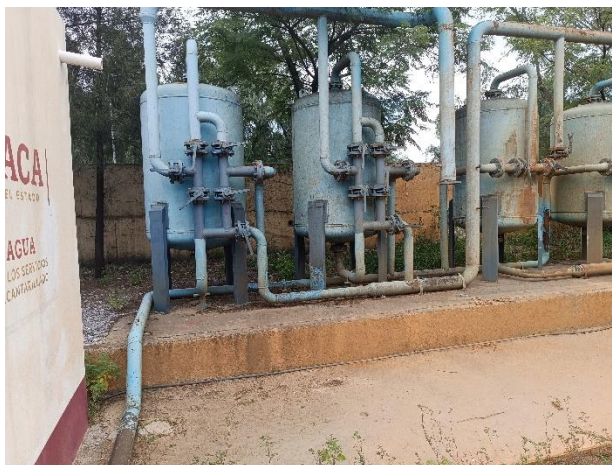
IMAGEN 1. VISTA DEL TREN DE DESCARGA DEL POZO EXISTENTE. A UN COSTADO SE APRECIAN LAS PLANTAS DE TRATAMIENTO A PIE DE POZO, LAS CUALES ESTÁN CONSIDERADAS PARA SU RETIRO COMO PARTE DE LOS TRABAJOS DE REPOSICIÓN.
